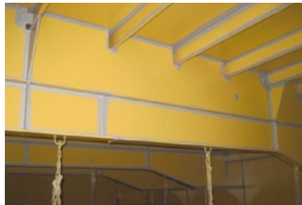
ストライプコート(グレー)2回目塗装後
