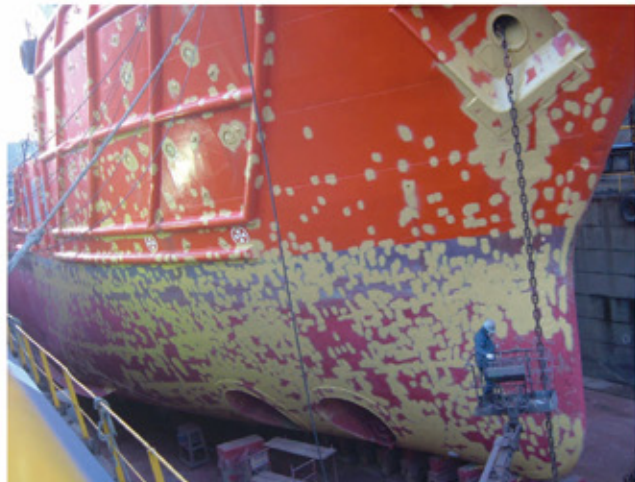
[仕様]NOA 10 M バフ 250 \mu m \times 1 T/U [解説]NOA 10 M によるピンポイント&ワンショットタッチアップ
